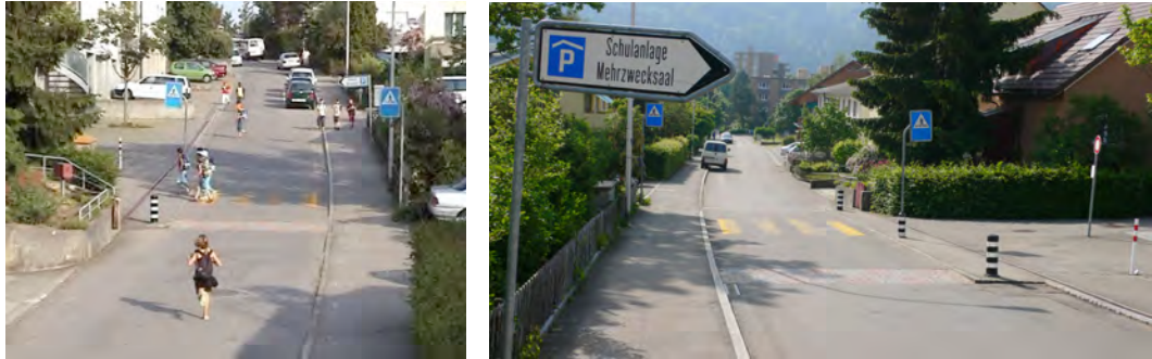
Abb. 5.12 und 5.13 Tempo-30-Zone Schlieren Köniz mit vertikalem Versatz beim Schulanlageingang. Der im Bild noch sichtbare Fussgängerstreifen wurde unterdessen nicht mehr erneuert, weil er unzweckmässig ist.
