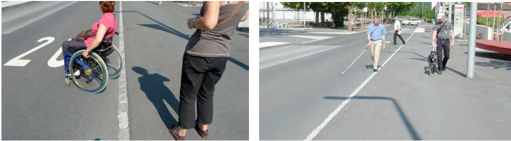
Abb. 5.30 und 5.31 Die Begegnungszone im Ortskern von Bremgarten ist ein gutes Beispiel für die Abtrennung des weitgehend den Fussgängern vorbehaltenen Raumes und der Fahr-Verkehrsfläche. Ein schräggestellter Randstein erlaubt das taktile Erfahren mit dem Taktstock ohne das Überfahren mit dem Rollstuhl oder Rollator einzuschränken. Zu beachten gilt allerdings: Die klare Unterscheidung von Fahrbahn und Randbereich hat unter Umständen zur Folge, dass die Geschwindigkeit schlechter eingehalten wird, da eine solche Gestaltung eher zu schnellerem Fahren animiert.
