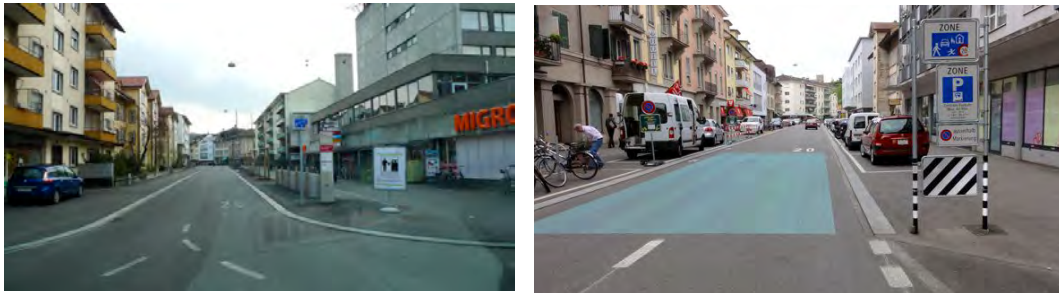
Abb. 7.3 und 7.4 Bern Mittelstrasse vorher und nachher. Rechts: Verbessertes Eingangstor West mit tieferem Signal und Farbgestaltung.
