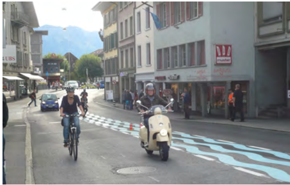
Abb. 8.2 Flächiges Querensystem in Thun; Die blauen Wellen dienen als Mittelzone. Das V85 im Regime „generell 50 innerorts“ liegt tagsüber bei 25km/h und der Schnitt über 24 Stunden bei 30km/h. Die durchschnittliche Durchfahrtszeit der Motorfahrzeuge und die Wartezeit der Fussgänger sind gesunken. Pro Jahr entfallen Kosten von rund Fr.200'000.- für hinfällige Verkehrsdienste.
