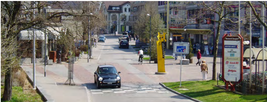
Abb. 1.2 Begegnungszone auf der ursprünglichen Flanierzone in Burgdorf
